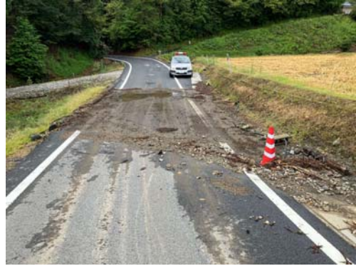
市道飯地町15号線 土砂流出
