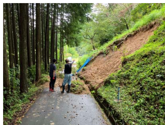
飯地町 法面崩壊
