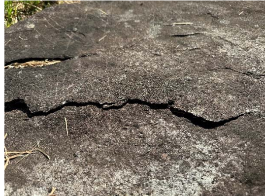
図2 礎石表面に発達する剥離・浮き
