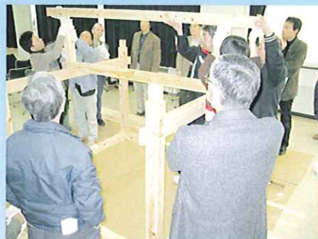
伝統構法の軸組模型組み立ての様子
