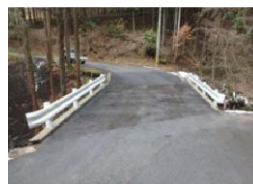
暗井沢4橋補修工事
