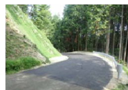
林道維持工事
