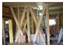
木造住宅耐震補強工事
