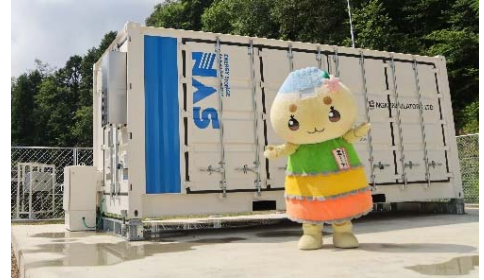
▲蓄電池による避難所への電源供給
