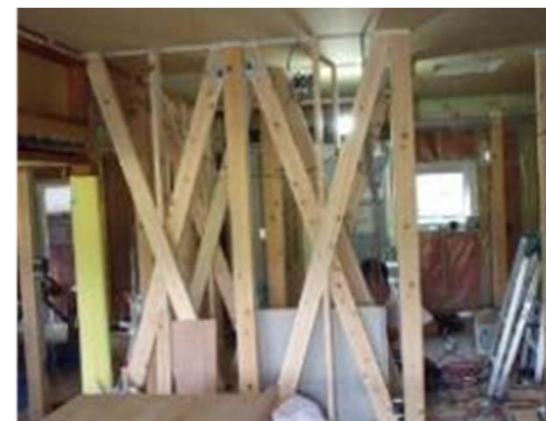
木造住宅耐震補強工事
