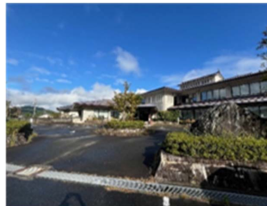
改修前の旧岩村振興事務所
