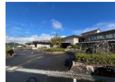
改修前の旧岩村振興事務所
