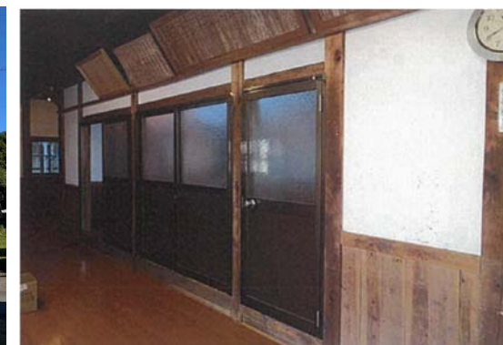
宮盛座（佐々良木公民館）改修前
