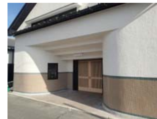
宮盛座（佐々良木公民館）改修後
