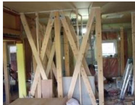
木造住宅耐震補強工事
