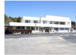
整備後の飯地コミュニティセンター
