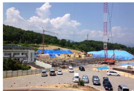
▲平成 28 年 9 月末の完成を目指し建設中の市立恵那病院再整備事業
