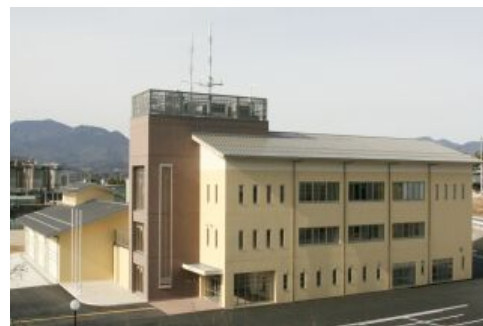
▲恵那市消防防災センター
