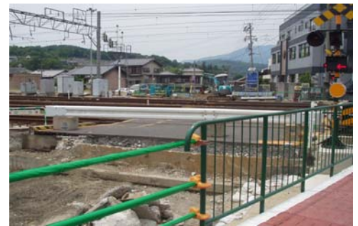
▲恵那駅東側で行われる南北踏切拡幅工事
