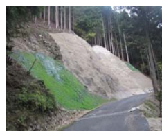
林道 暗沢線改良工事
