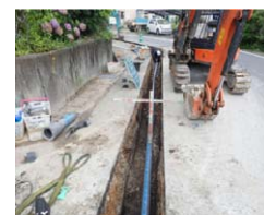
配水管布設替工事
