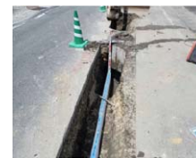
配水管布設替工事
