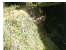
林道 木根中島線修繕工事
