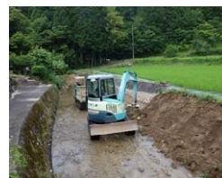
普通河川の浚渫状況
