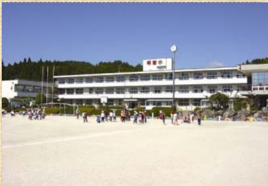
【明智小学校校舎耐震補強 及び大規模改造事業】
