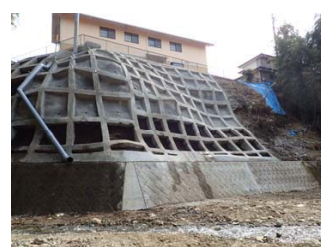
急傾斜地崩壊対策箇所
