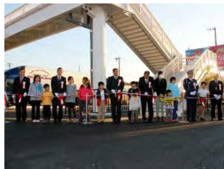
▲国道 19 号原交差点に歩道橋が完成
