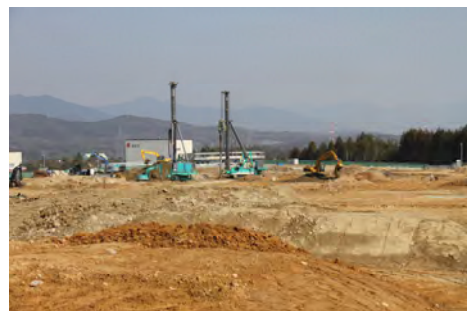
▲分譲が完了し工場を建設中の第3期恵那テクノパーク
