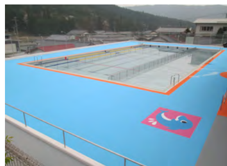
▲完成した中野方小学校プール
