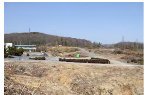
▲立木の伐採を終えた市立恵那病院再整備事業の建設場所
