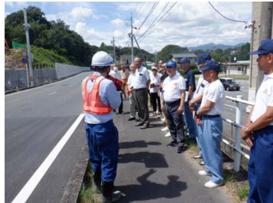
リニア中央新幹線工事現場視察の様子
