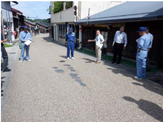
本通り舗装の劣化箇所視察の様子
