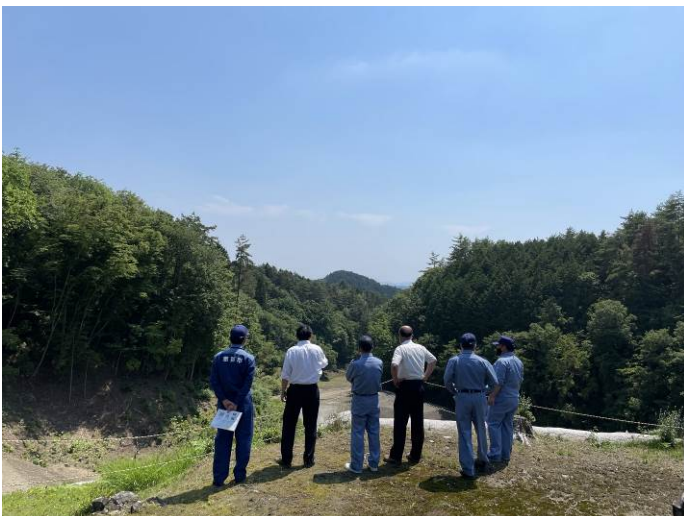
国道418号線付替道路建設現場視察の様子
