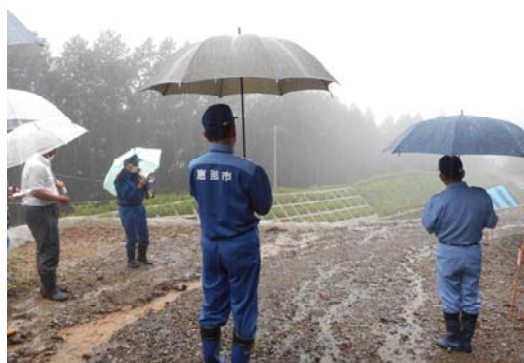
国道418号線付替道路 建設現場視察の様子
