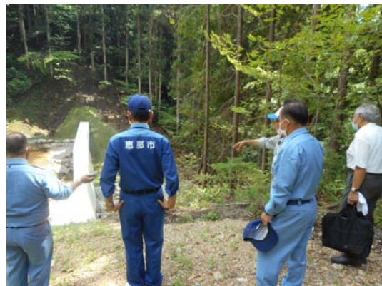
治山事業箇所視察の様子
