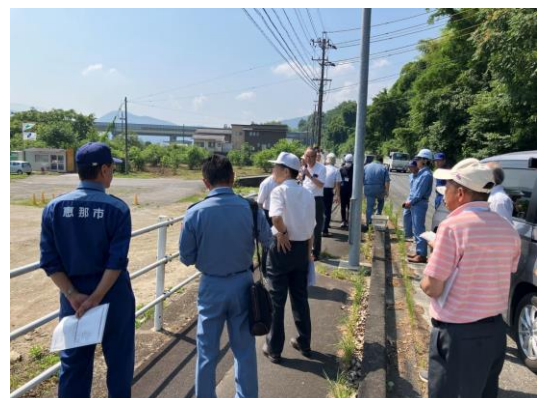
阿木川架橋工事現場視察の様子
