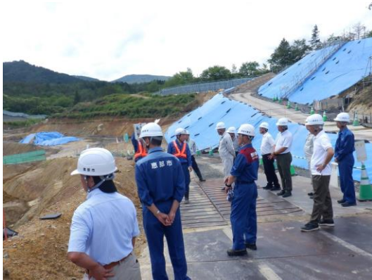
リニア中央新幹線トンネル工事現場視察の様子
