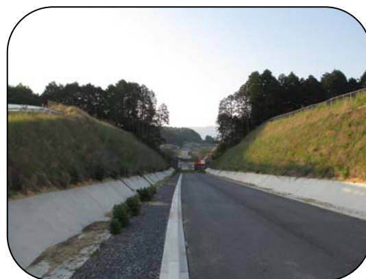
○建設中の新東雲橋
