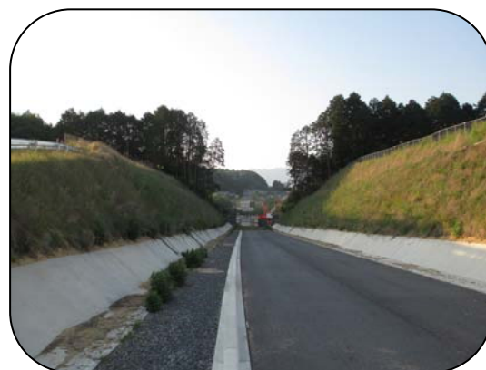
○建設中の新東雲橋
