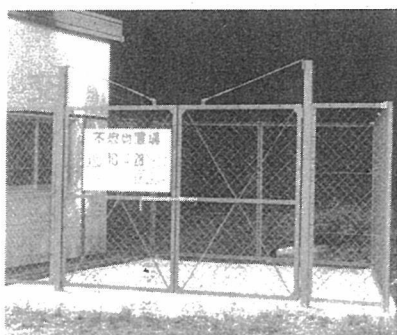
完成した収集所
