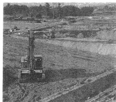
工事中の屋下地区
