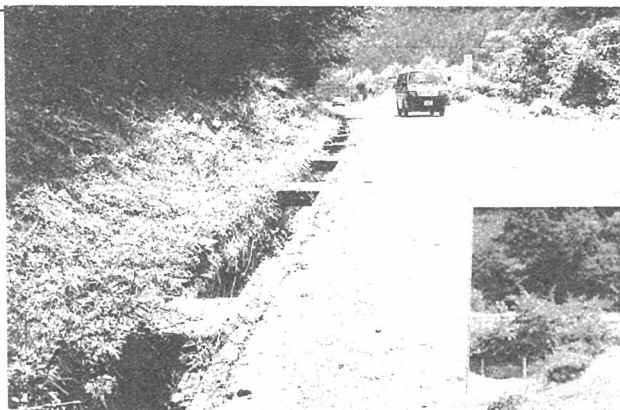
作業の終わった道路
