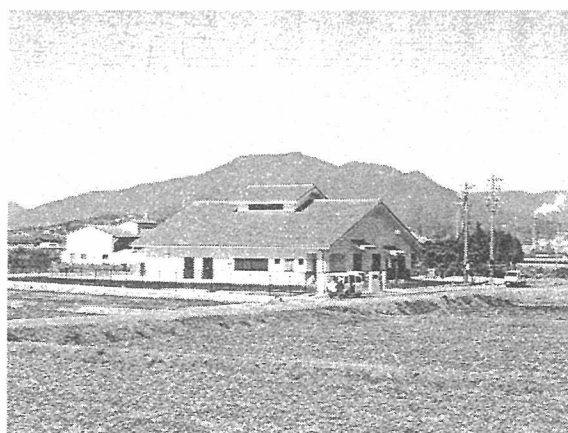
東野クリーンセンター（処理施設）
